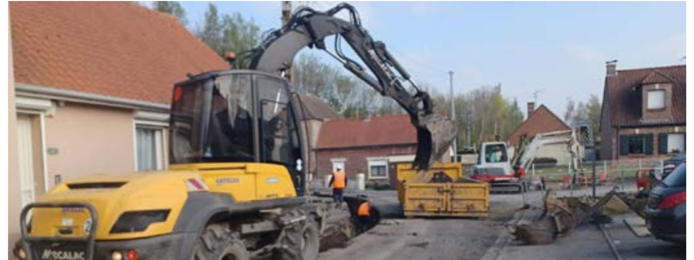
Travaux - rue Pressé
