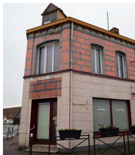
Réhabilitation du local pour accueillir une nouvelle boucherie
